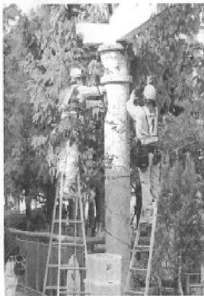
電飾を取り付ける作業の様子
